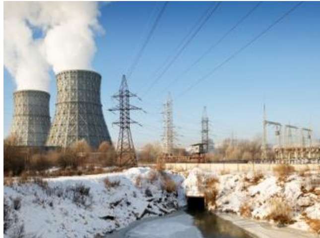
Figuur 38: In die winter is dit maklik om te sien hoe warm water uit die verkoelings torings van 'n kragstasie 'n ysbedekte rivier smelt
