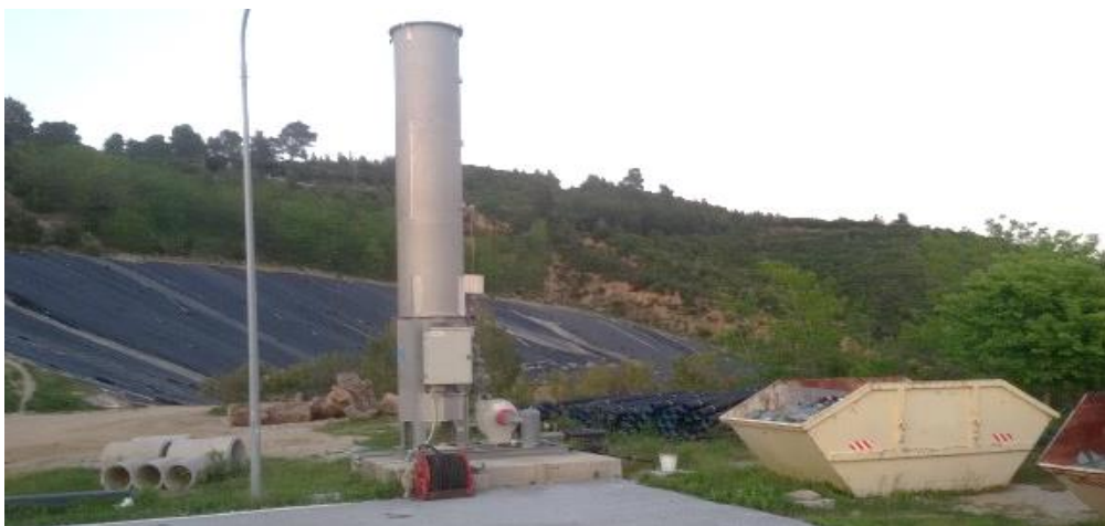
Figuur 77: 'n Verseëldde stortingsterrein met biogas pype en 'n vullis skip houer
