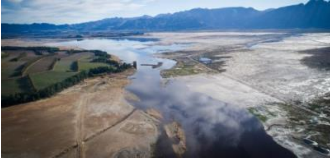
Figuur 30: Lug beeld van dorre aarde wat blootgestel is deur die byna leë Theewaterskloof dam tydens die ernstige droogte in die Wes-Kaap in 2018
